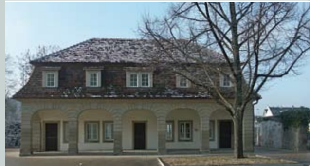
Pflugfelder Torhaus, Pflugfelder Straße 38 (Bahnhof Westportal, neben der ARENA)
